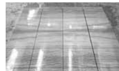
Esempio di pavimento a vena ricorrente e a macchia aperta / Example of flooring with repeated vein and book matched
